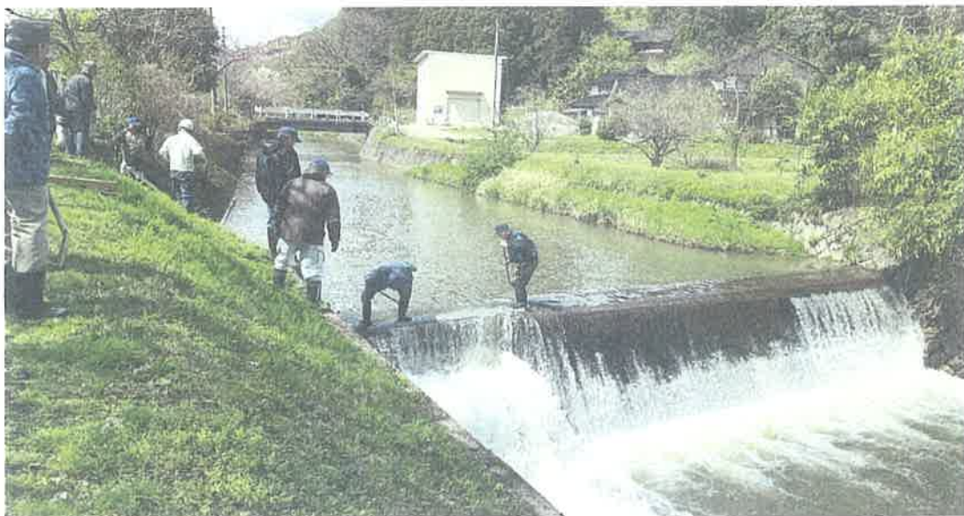
② 水門開放 作業風景
