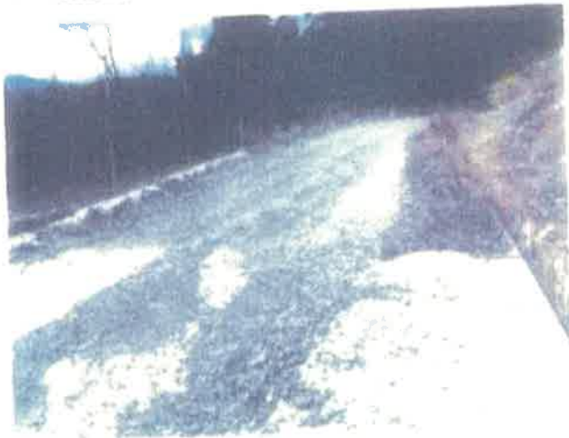
7 林道床鍋・池田線開通区間砂利箇所をコンクリート舗装
