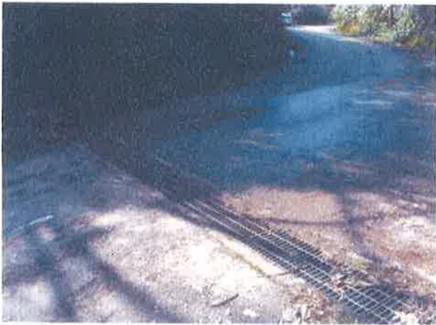
5 市道池田・鉢根線側溝の改良
