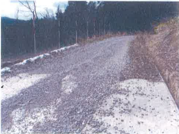
7 林道床鍋・池田線開通区間砂利箇所をコンクリート舗装
