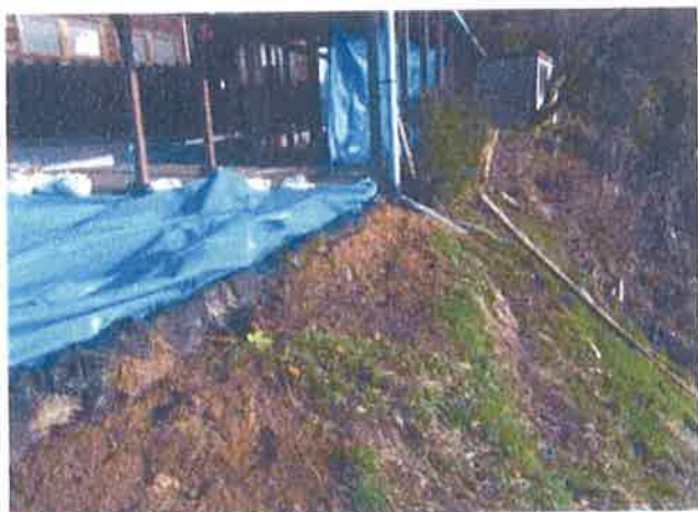
9 永福寺県道側斜面の亀裂改修及び急傾斜工事
