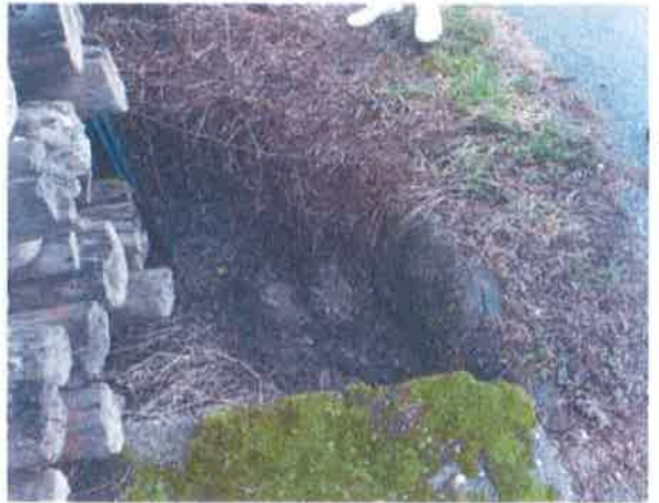
6 前田里美宅市道の暗渠排水溝の改良
