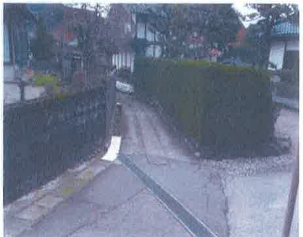
8 守谷彦平宅前の道路・水路の改修
