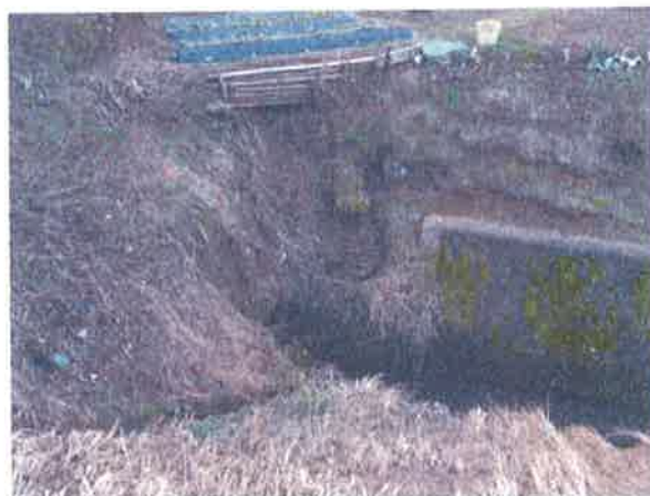
10 藤板英明宅前市道下の大谷内川暗渠部分の改修
