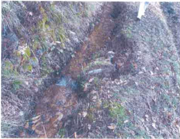
3 「子浦谷内の池」下排水溝の補修
