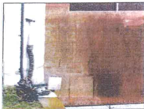
扉体の腐食によるあて板補修
