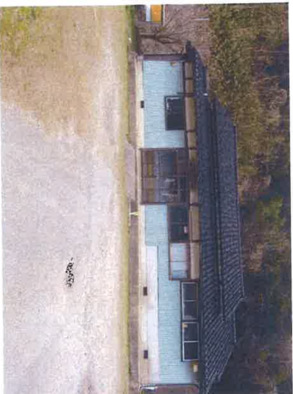
要望事項一⑧ 鞍骨公民館 舗装要望箇所
