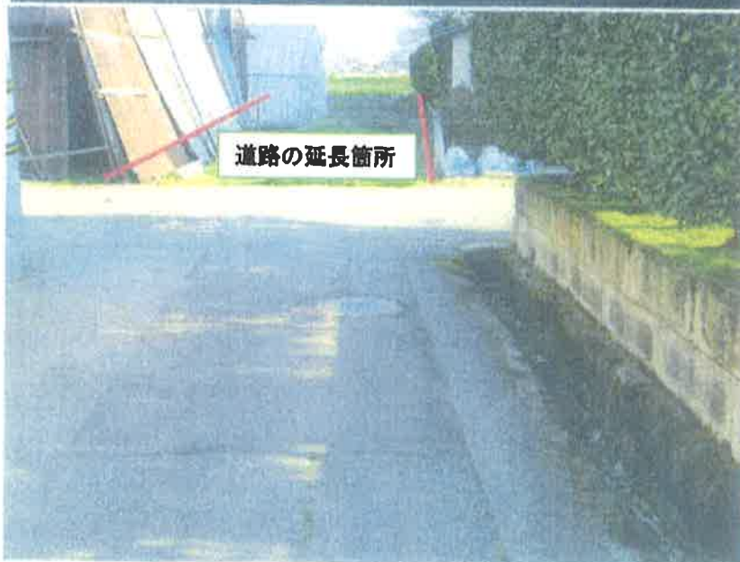
③ 宅横の側溝 写真
