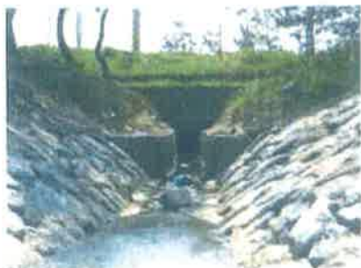
1) 駅側より 2 本目排水路
