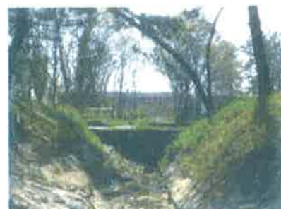
3) 駅側より 6 本目排水路
