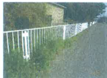
参考(フェンス南側)
