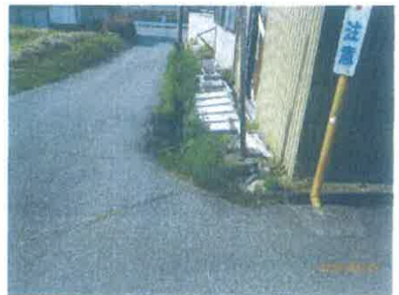
余川宅向側溝
