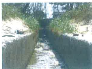
2) 駅側より 5 本目排水路
