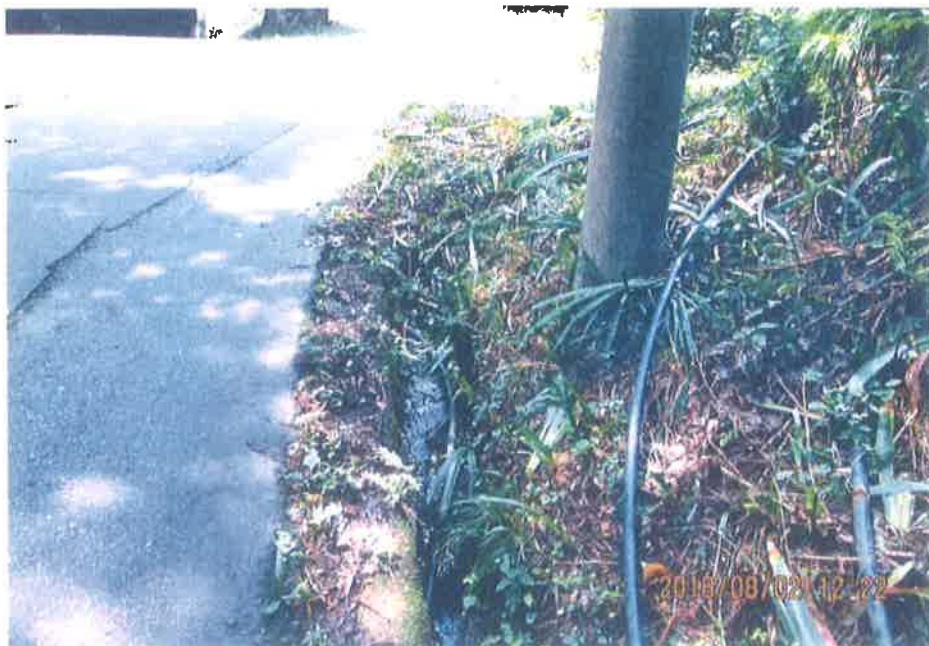
現在の道路側溝
