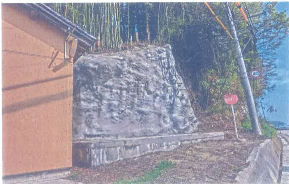
復旧工事施工後（平成 28 年 4 月 14 日撮影）
