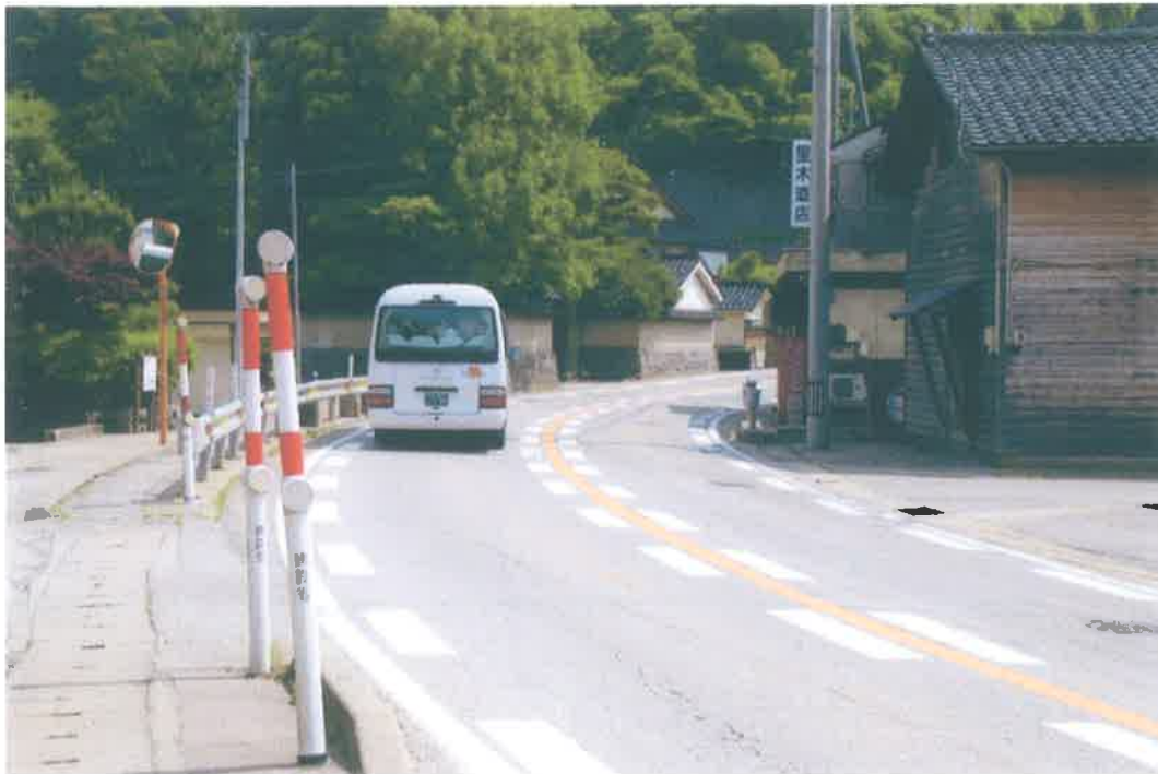
① 国道 160 号線（泊地内：里木酒店前）
