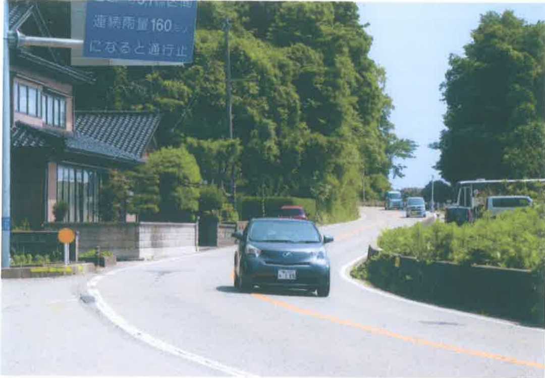
① 国道 160 号線（宇波地内：うみあかり前）
