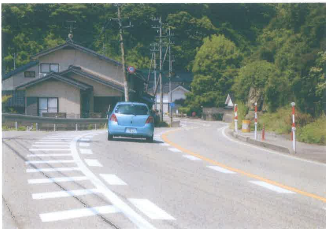
② 国道 160 号線（泊地内：里木昭男宅付近）
