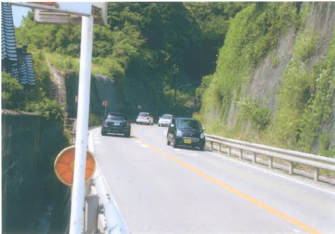
② 国道 160 号線 (藪田トンネル→旧藪田小)
