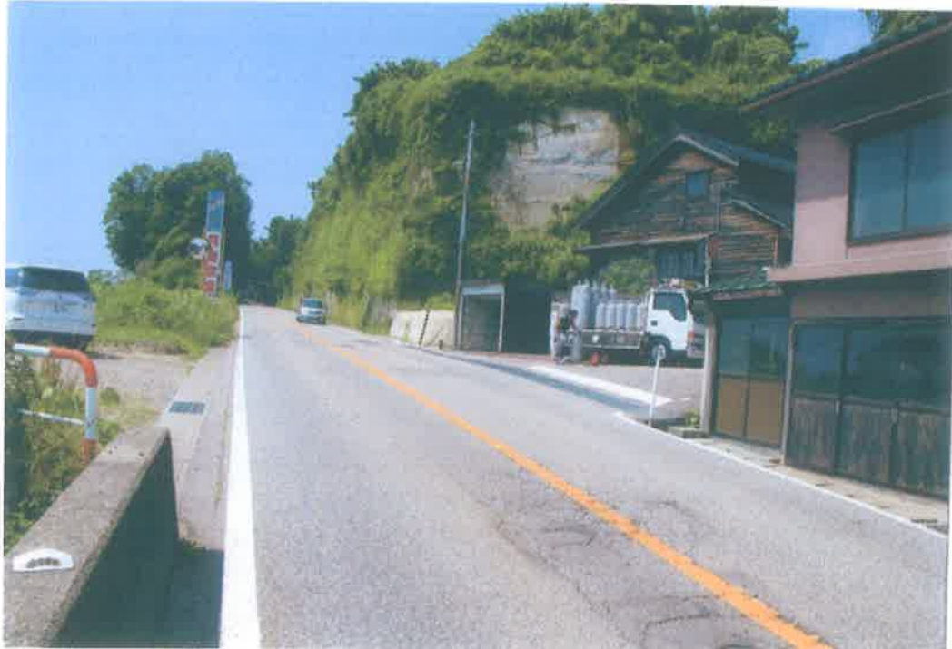
② 国道 160 号線（宇波地内）
