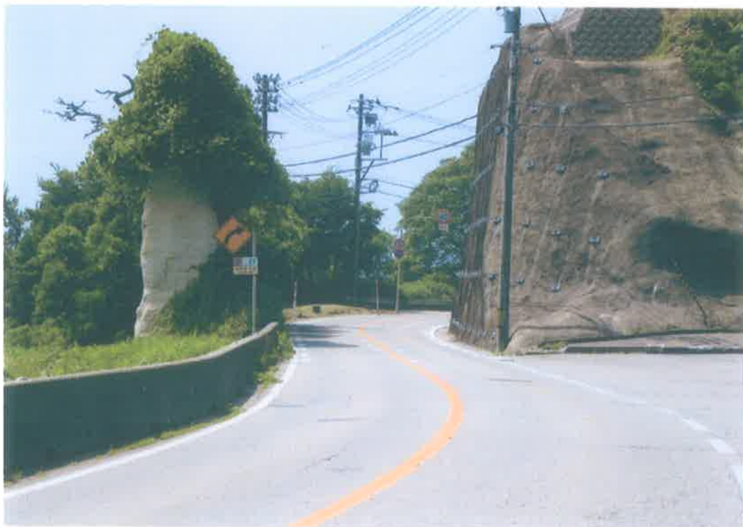
② 国道 160 号線（宇波地内：一石山付近）
