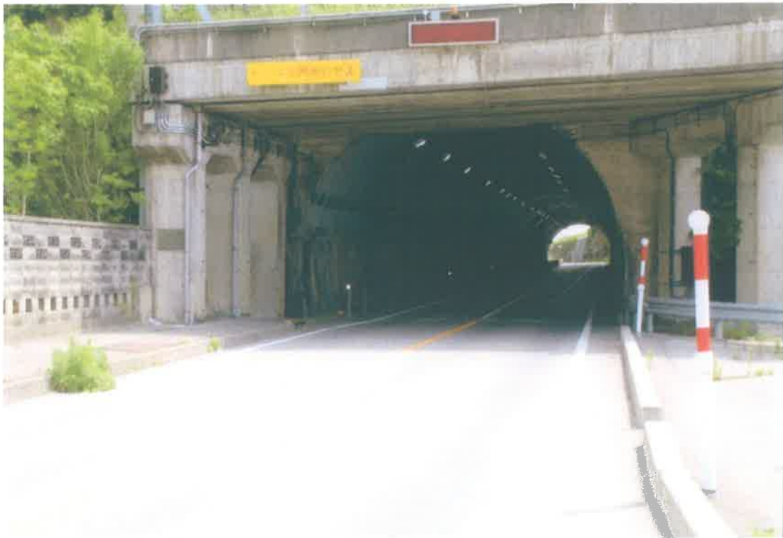
① 国道 160 号線 (藪田トンネル入口)
