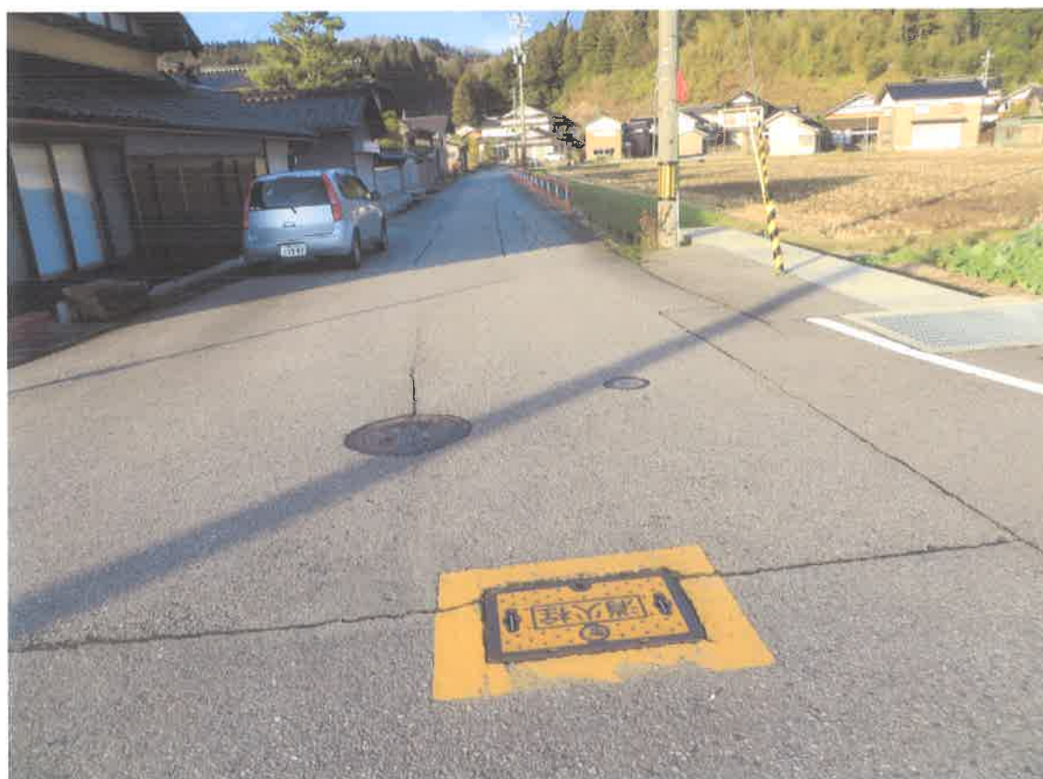
消火栓（市道七分一山際線の県道接続付近）
