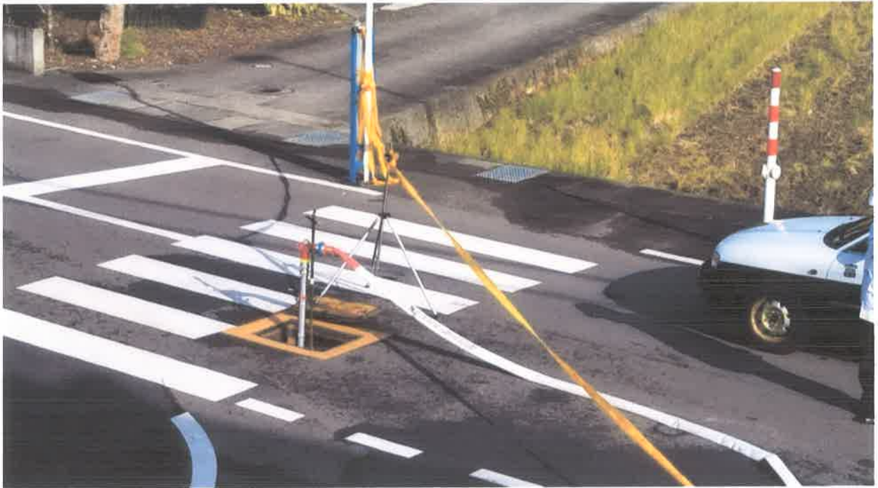
消火栓(七分一公民館前)
