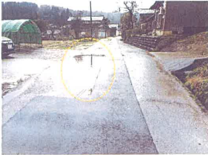
⑤陥没箇所の修繕
