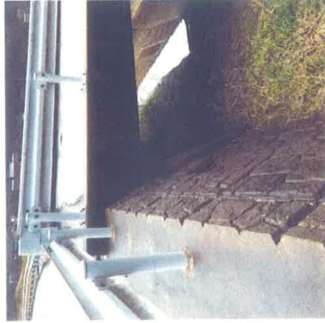
⑥ 能越道の下の箇所 ブロック亀裂、破損
