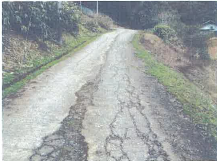
中間点より 上部を望む
