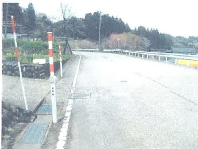
中間点より 上部を望む
