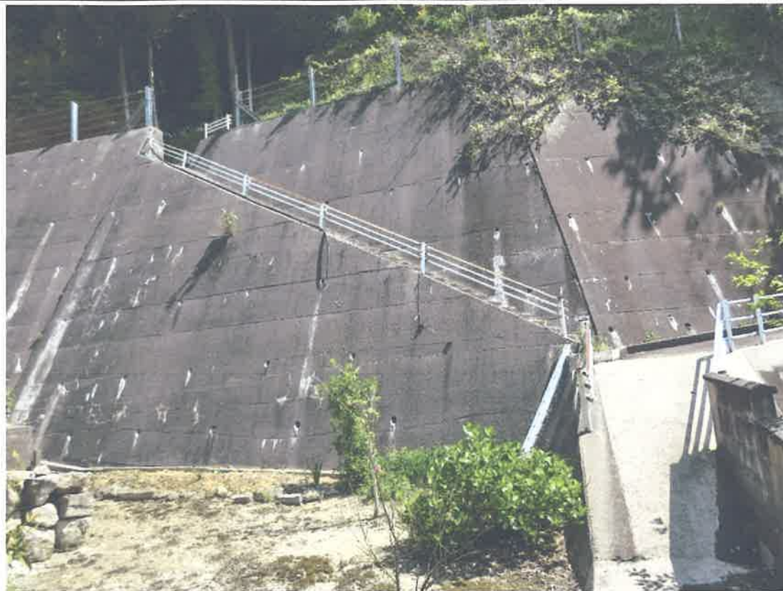
写真 1：急傾斜擁壁部における階段の設置例（R元年 4月撮影）
