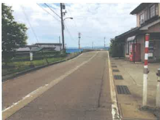
島崎橋（島崎方向より）
