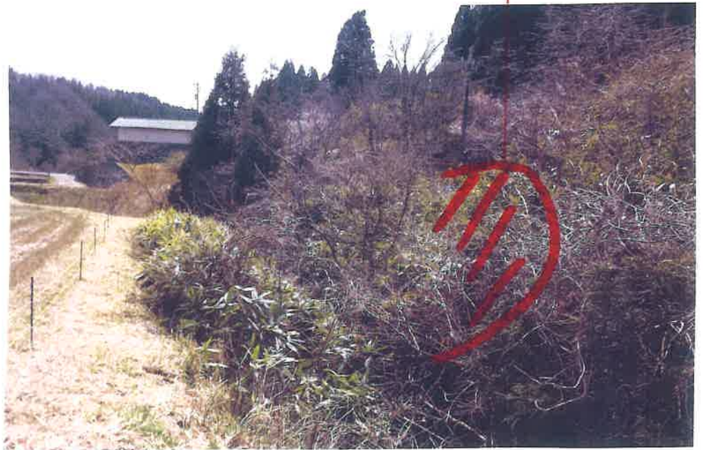
地割分析(下流側より)
