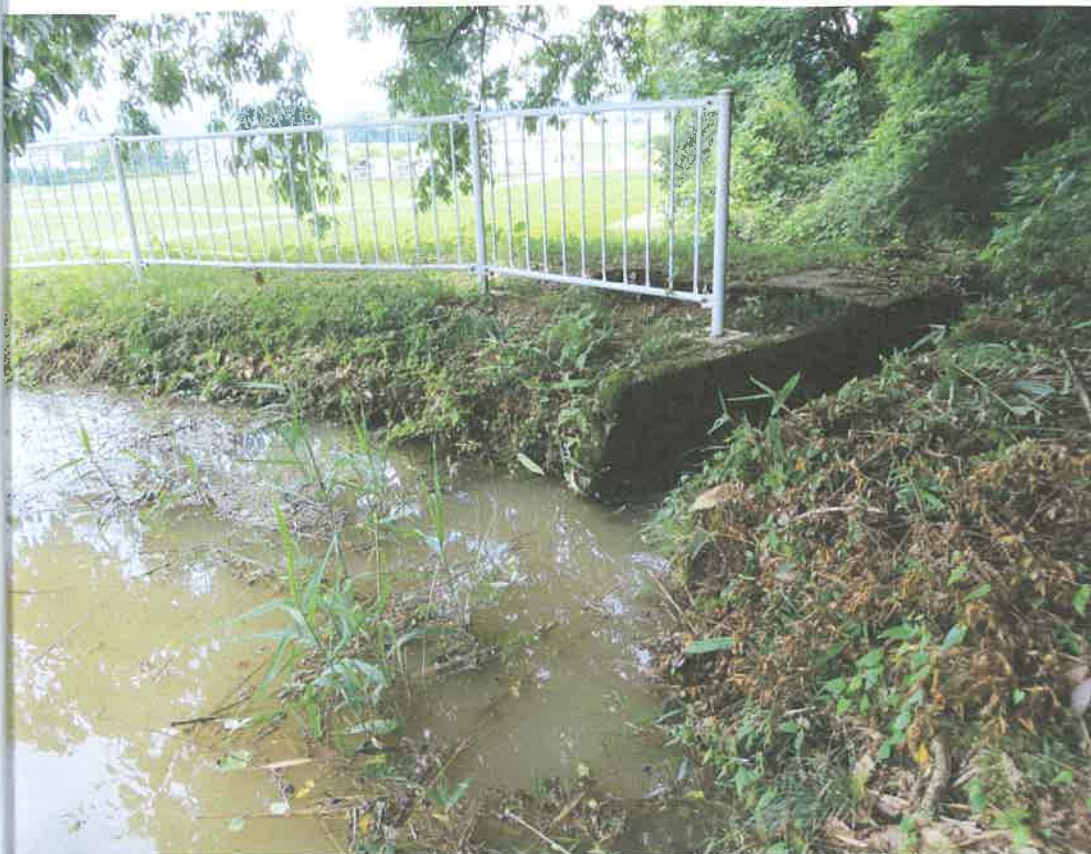
ヶ谷内池余水吐けの状況
