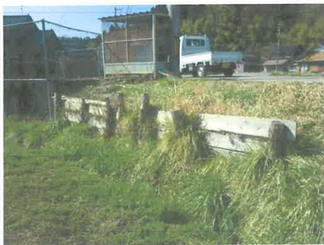
路肩の泥止めが老朽化して崩壊寸前
