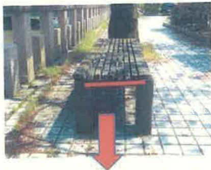
・錆びて危険である。(反対側も同様)
