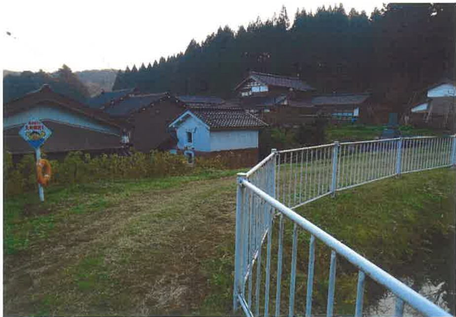
堤体より下流を望む (直下に人家有り)
