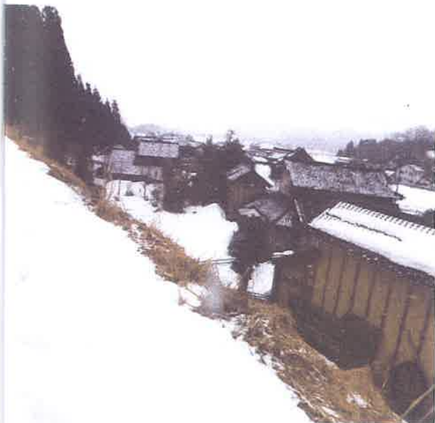
二階建て納屋の棟より高位置にある 堤体上部
