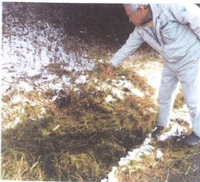
指差で示す箇所から漏水
