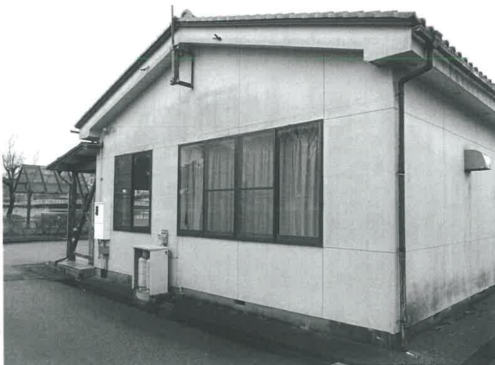
東側の外壁も西側や北側に比べて傷みが少ないように見える。
