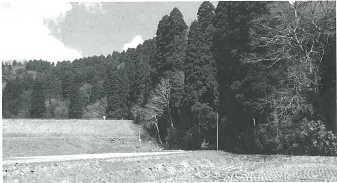
左手が八幡池の堤体盛土、右が地山の麓。山に沿って用水路が引かれている。
