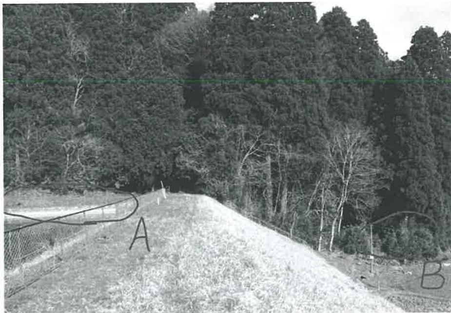
漏水箇所とされる八幡池のブロック壁(A)と、出水箇所(B)と思われる地山の場所。
