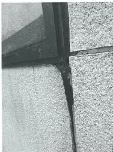
写真左は、窓のサッシ部。写真右は、壁のいたるところにめくれやヒビ割れが発生。
