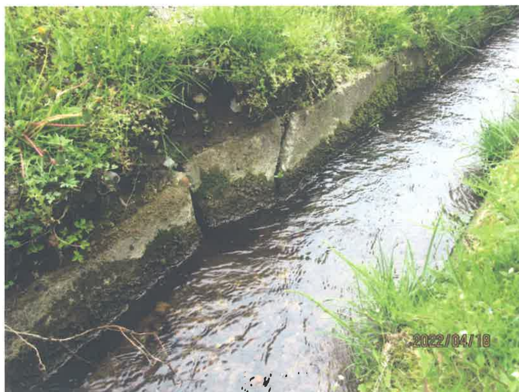
令和2年除雪車により破損した箇所
