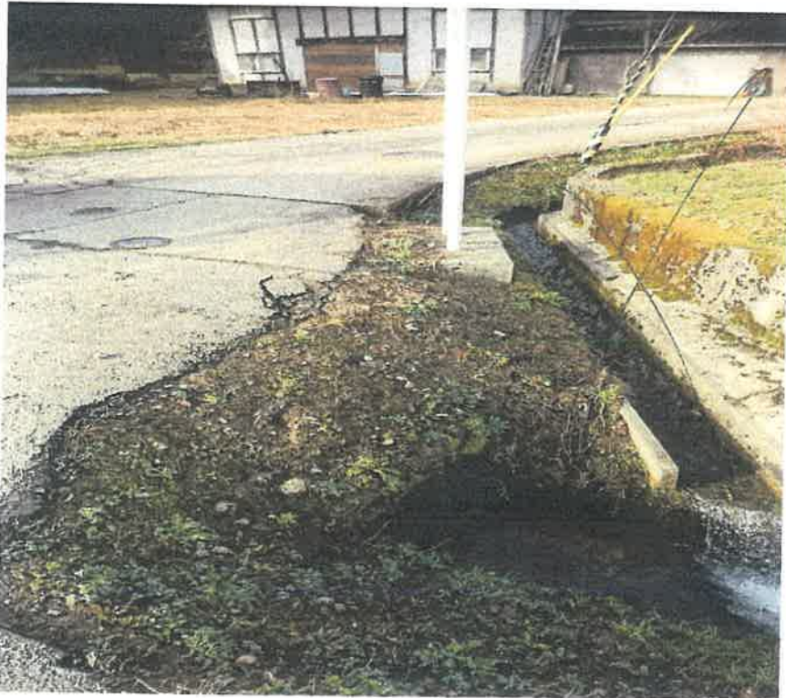
② 路肩補修
