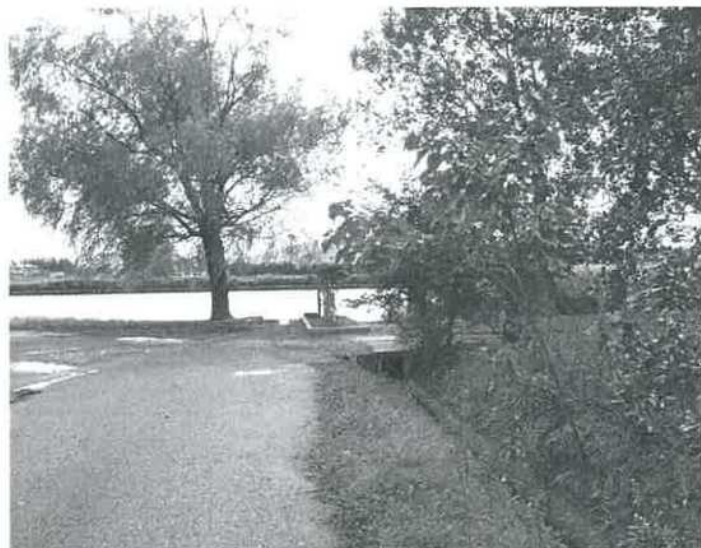
○普段の大排水路(令和4年10月11日)
