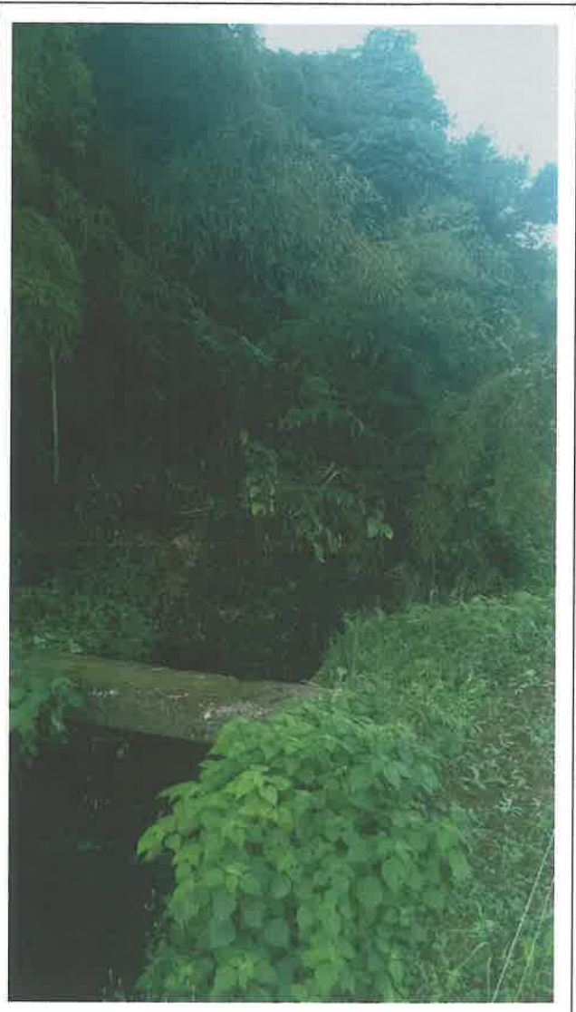
五郎平水門付近の法面 遠景
