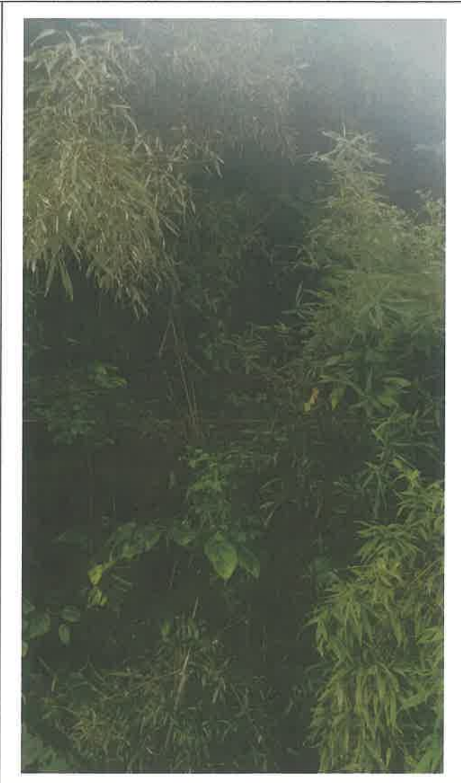
五郎平水門付近の法面 中央部
