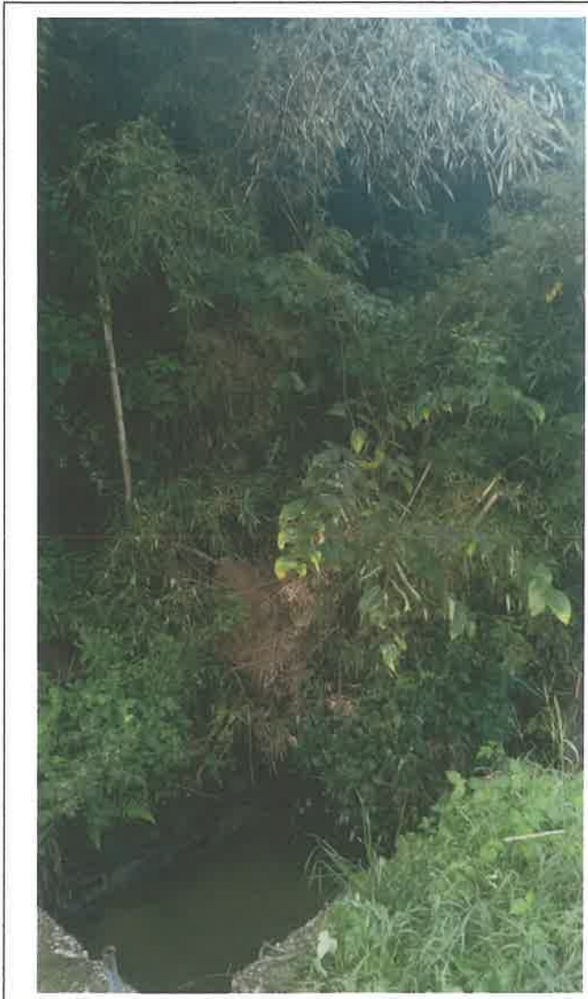
五郎平水門付近の法面 近景
