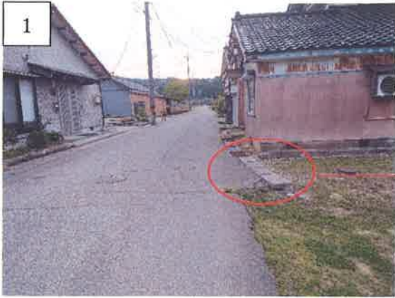
1 起点側：未整備の状況
