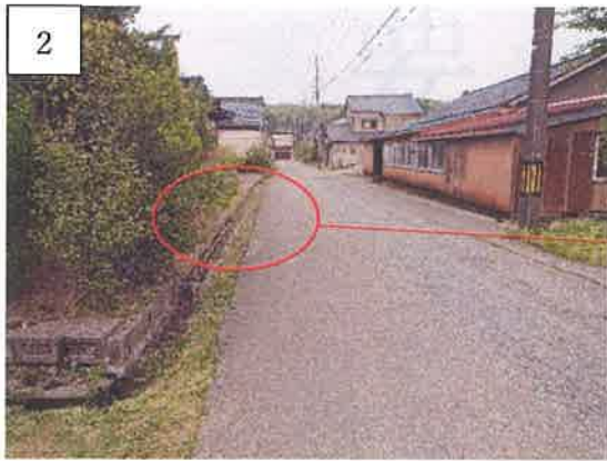
2 終点側：未整備の状況
