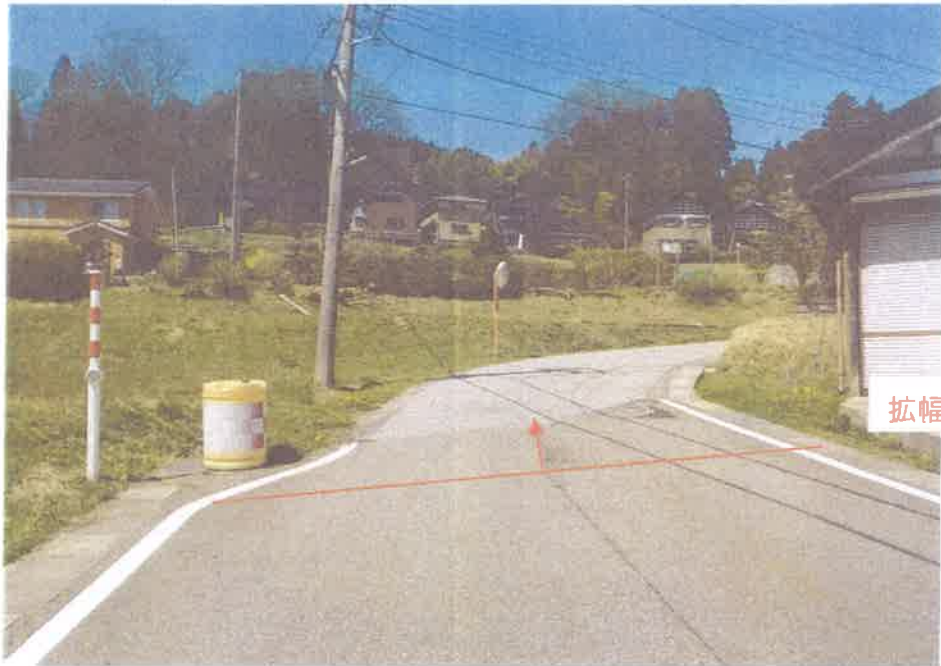
④市道論田菅池線 車庫前補修
