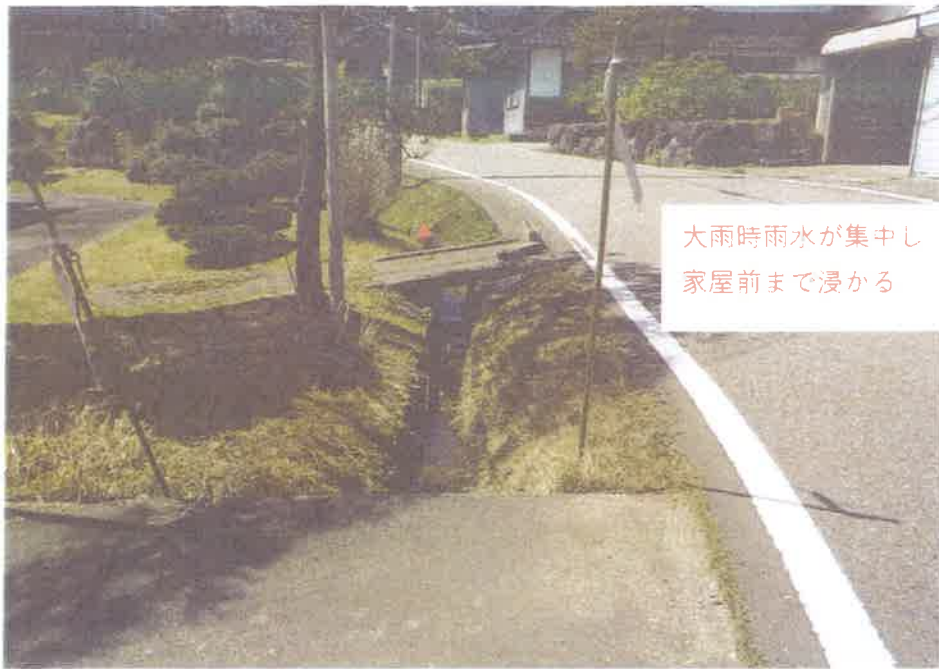
⑧論田菅池線水路の拡大（宅前）新
