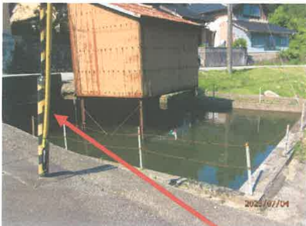
防火水槽約1m市道下に入っている
