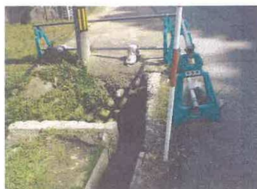
⑮ 側溝の破損
