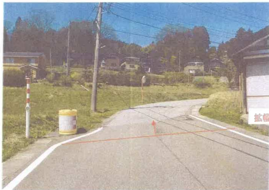
④市道論田菅池線 車庫前補修
