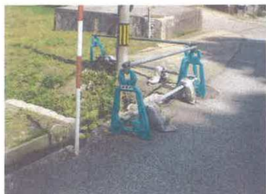
⑤ 付近 除雪車によると思われる損傷
