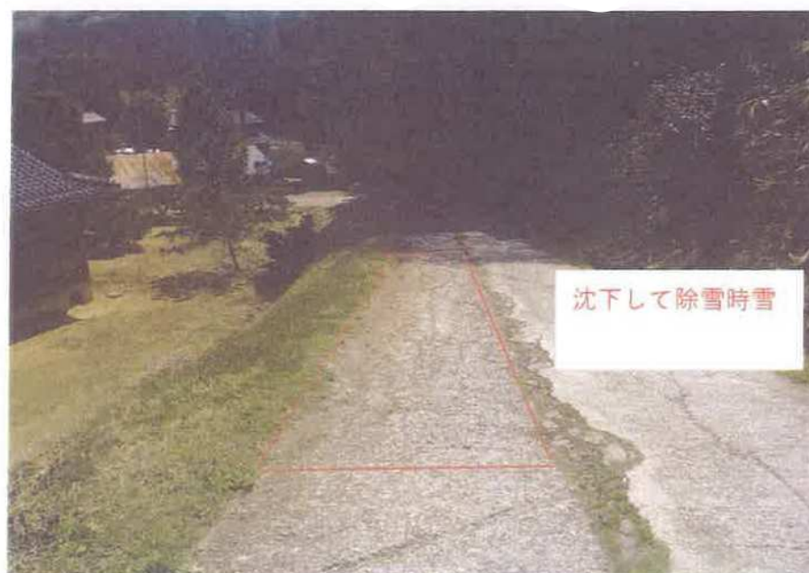
②市道内山線の道路中央～路肩沈下補修（ 車庫裏～ 宅中央付近まで）
