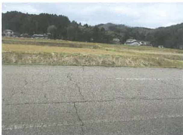
横断方向亀裂 多数
