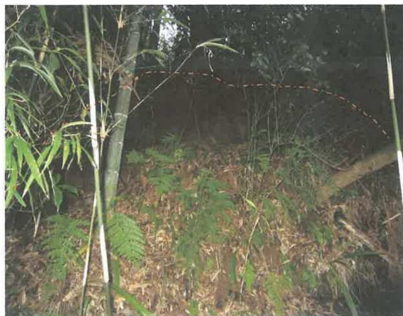
① 家裏斜面崩落亀裂 幅薬剤30m、高さ約10m 約
