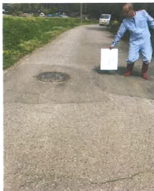
④地震による指導凸凹 車の走行に支障がある。
