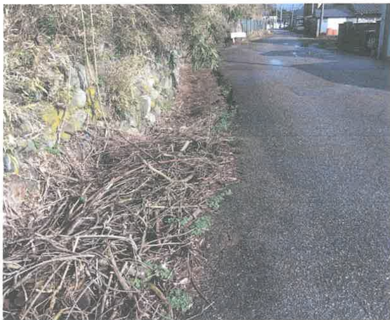
清水路肩側溝整備 (十二町3730下市道)
