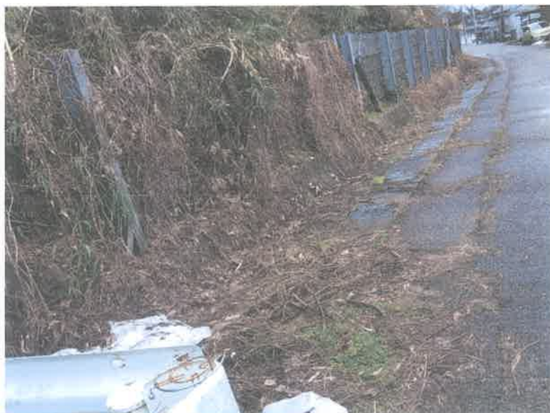
清水路肩側溝整備 (十二町3730下市道)
