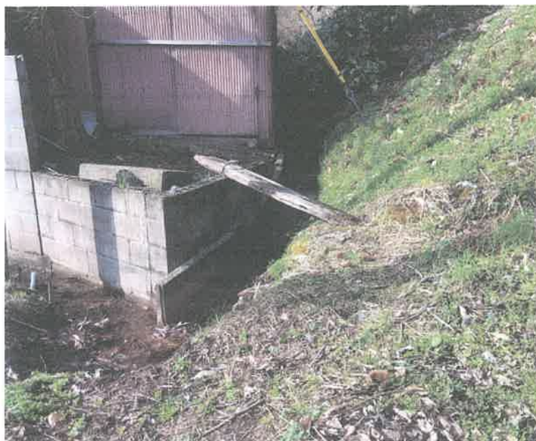
清水路肩側溝整備 (十二町3730下市道)
