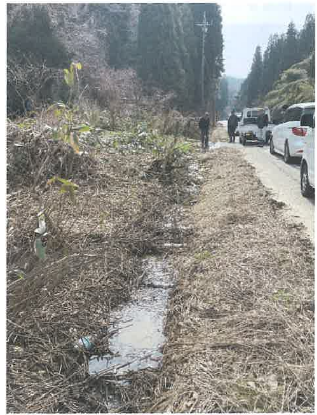
③ 市道堀田五十里線（旧広域農道）の側溝が土砂で埋まり排水があふれている箇所
