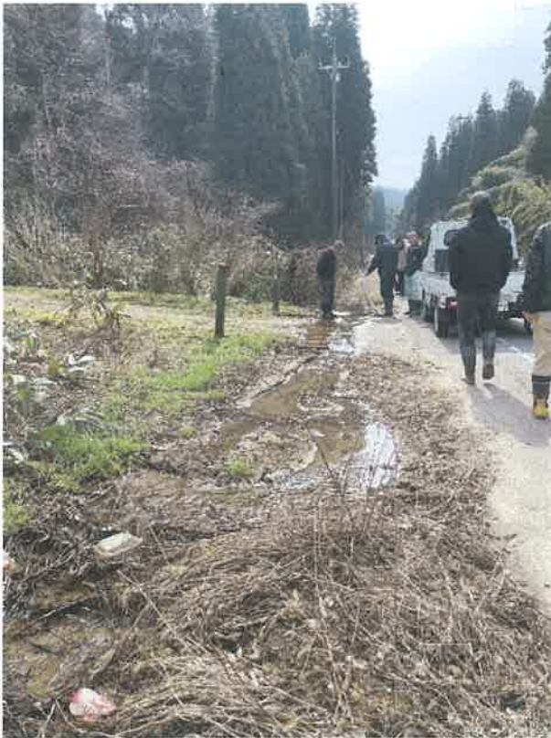
③ 市道堀田五十里線（旧広域農道）の側溝が土砂で埋まり排水があふれている箇所
