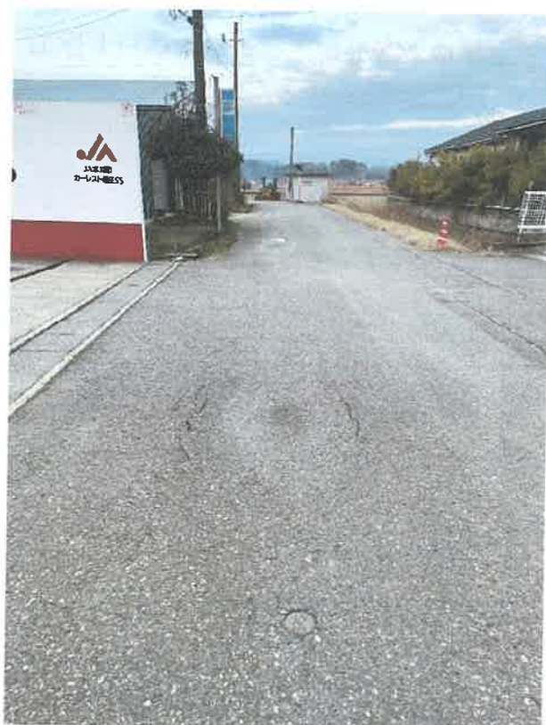
⑤ 市道のかんがい排水用水路管理設部分に能登半島地震による凹みや歪みがある箇所
