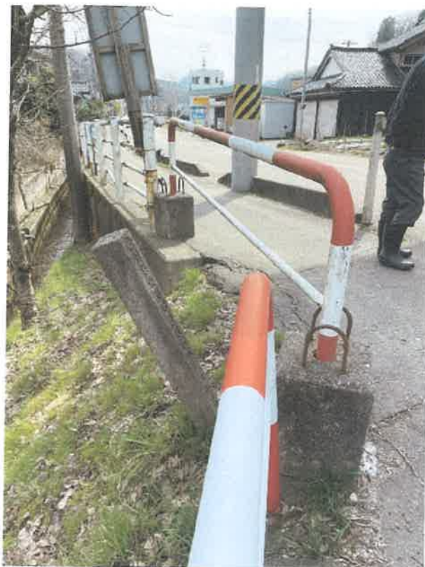
⑤ 市道のかんがい排水用水路管理設部分に能登半島地震による凹みや歪みがある箇所
