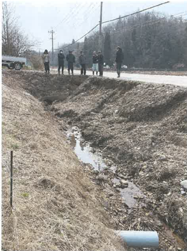
③ 市道堀田五十里線（旧広域農道）の側溝が土砂で埋まり排水があふれている箇所
