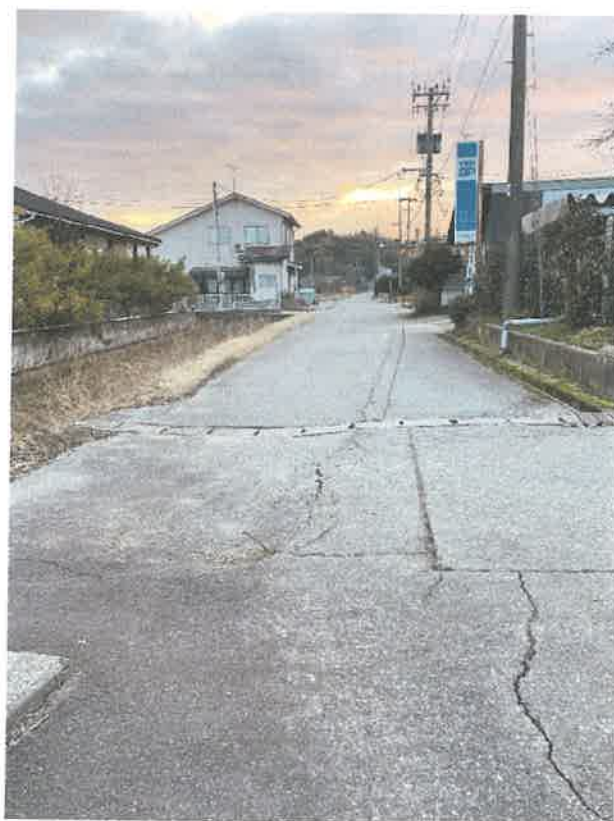
⑤ 市道のかんがい排水用水路管理設部分に能登半島地震による凹みや歪みがある箇所
