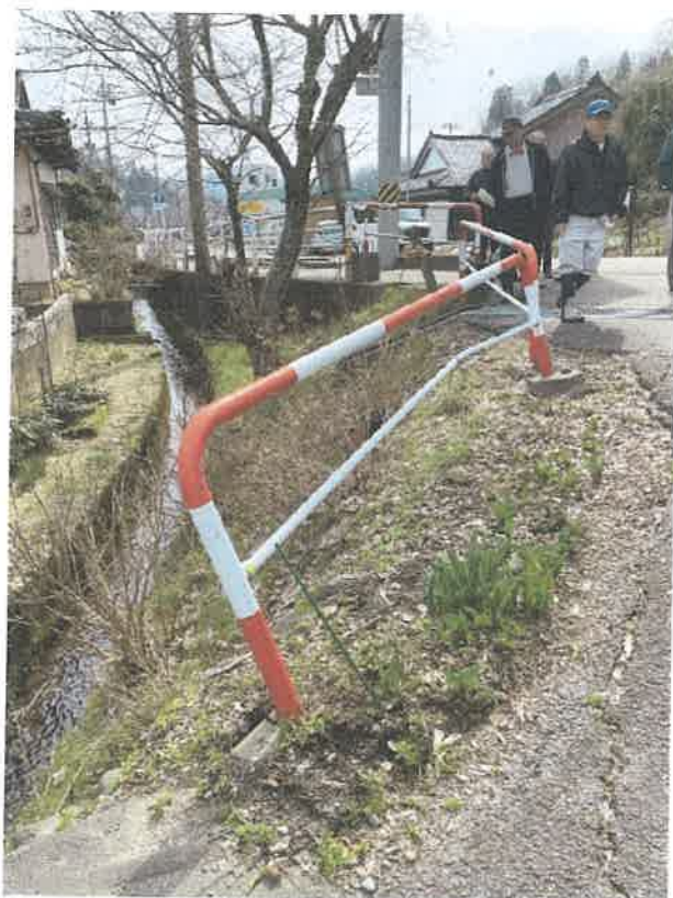
④ 市道法面のガードレールが今冬の除雪で破損している箇所
