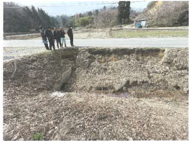
② 市道堀田海老坂線の路肩欠所の再復旧（昨年市が復旧工事を行った箇所）
