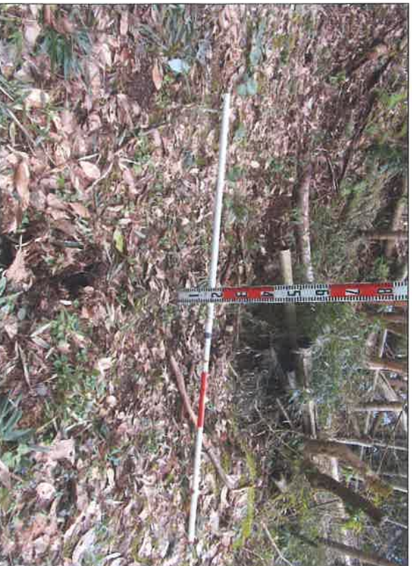
要望事項一② 地滑り調査・対策工事 滑落崖段差状況
