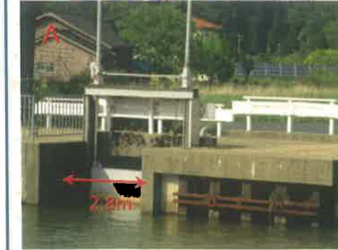
上流水門写真(開口2.8m)
