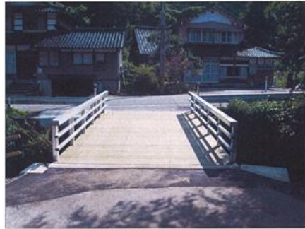
完成 左岸より
