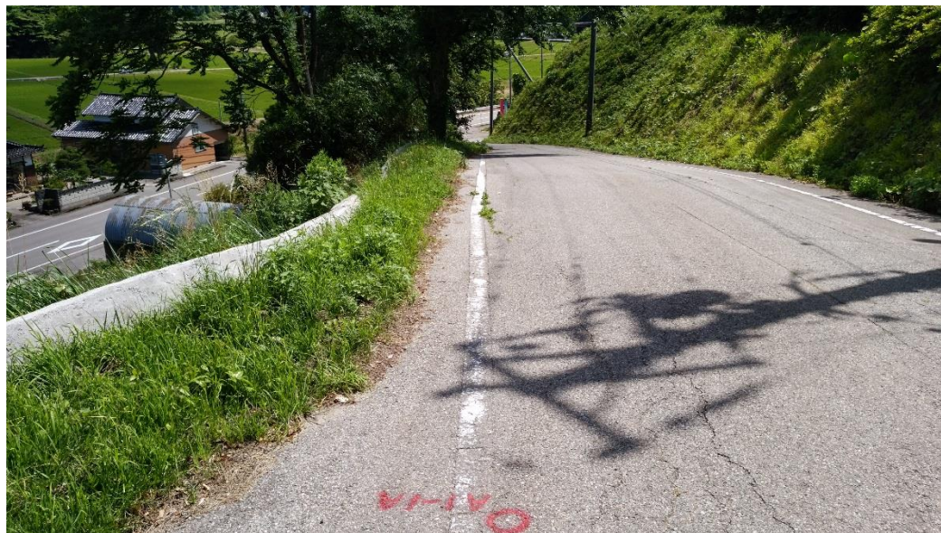
市道仏生寺小学校線のガードレールの設置要望箇所
